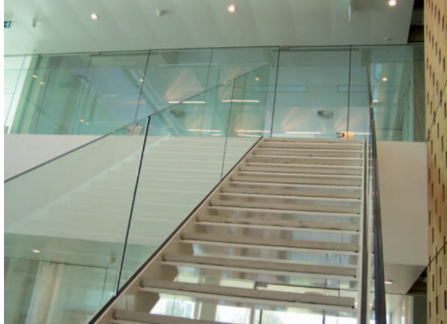
▲ Eenzijdig ingeklemde balustrade in een openbare ruimte.
