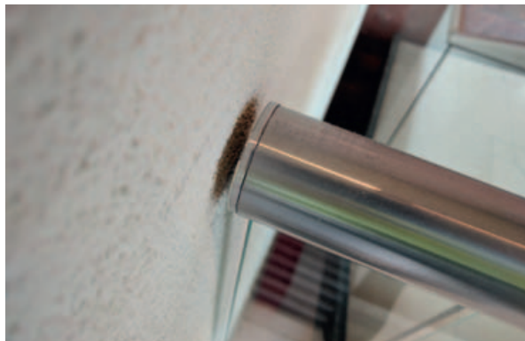
Volledig vlak afgeslepen randen zonder verschil tussen de glasbladen duidt op floatglas.
