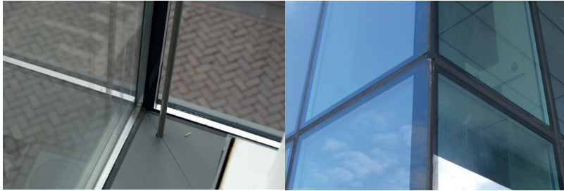
Structurele hoekverlijming van binnenuit en van buitenaf gezien.
