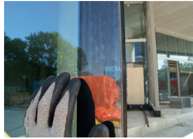
Coatingresten en de afwijkende kleur van het butyl zijn duidelijk zichtbaar.
