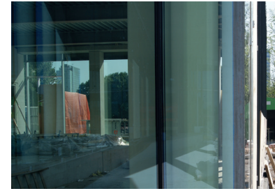
Zichtbare coatingresten en kleurverschillen in de randafdichting.
