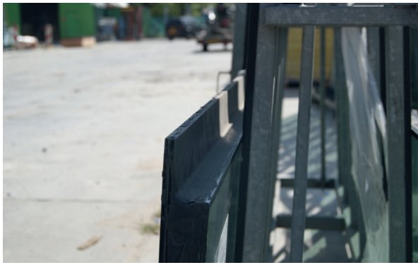
Achterzijde van een met siliconen kit zwart gemaakte overlap.
